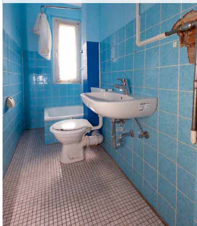
Aus einem kleinen Bad mit dem Fliesen-Charme der 1960er Jahre und alten Leitungen ...
